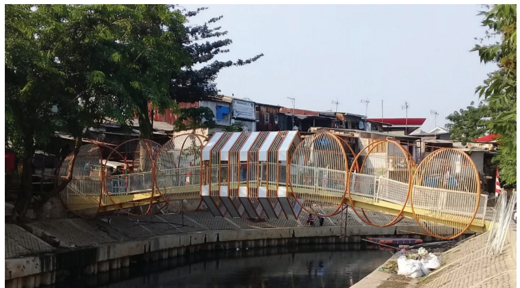
Jembatan yang berlokasi di Jakarta Barat, yang direnovasi setelah terdapat korban, dimana seorang anak terjatuh, disebabkan railing atau pagar jembatan telah rusak.
